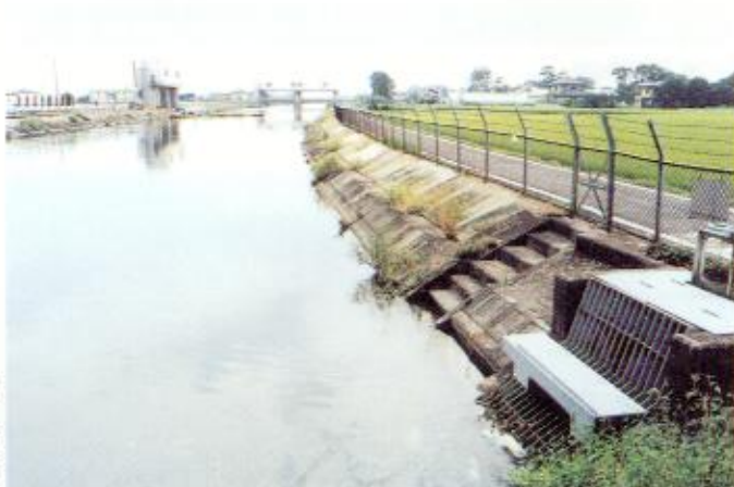
A Canal Right : Division box Top center : Check gates
