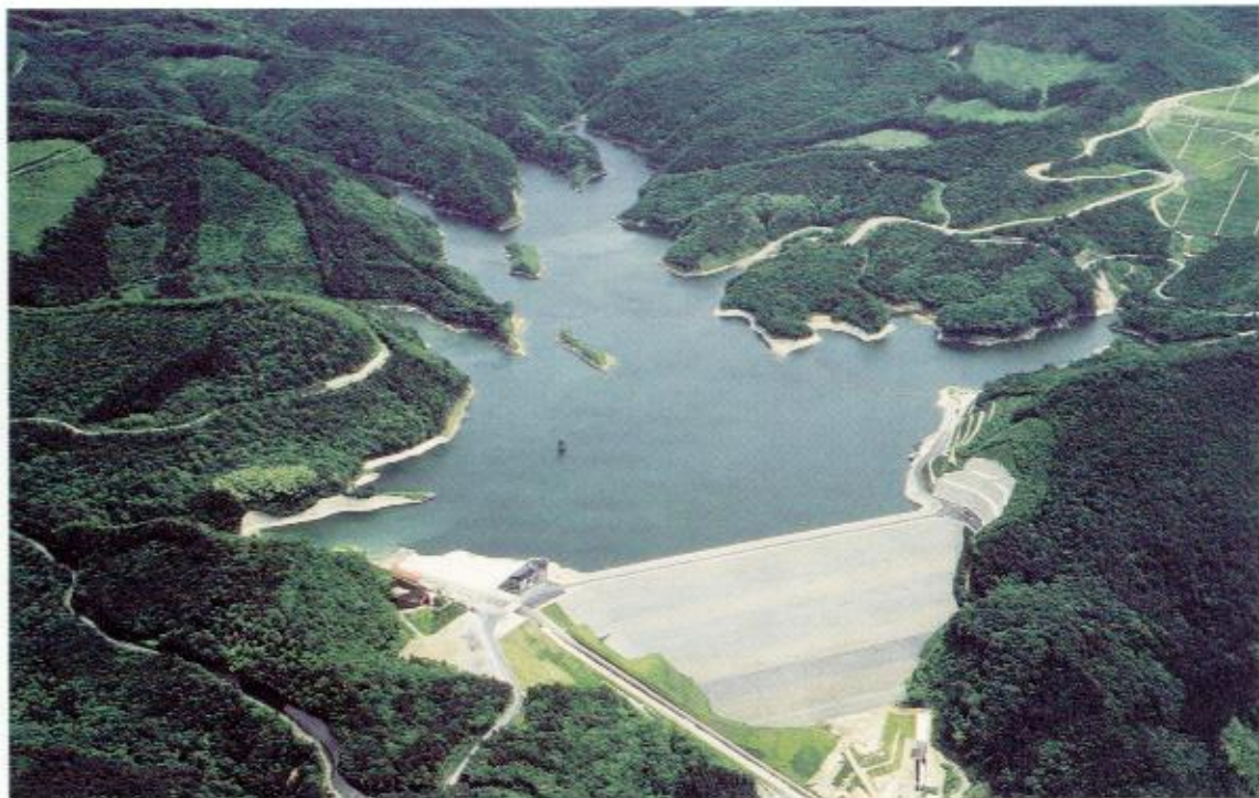
A rock fill dam
